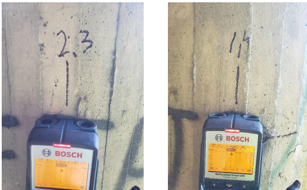
Figura 55 - Ensaio de pacometria - Identificação do posicionamento da armadura existente
