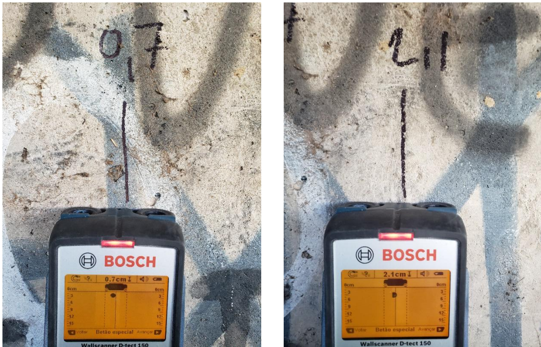
Figura 46 - Ensaio de pacometria - Identificação do posicionamento da armadura existente
