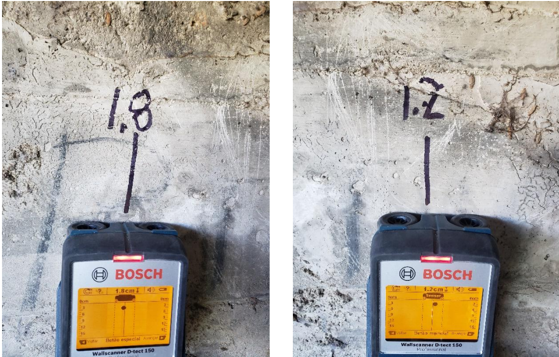
Figura 52 - Ensaio de pacometria - Identificação do posicionamento da armadura existente
