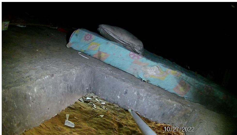
Figura 21 - interior do caixão - foi observada a presença de ocupantes dentro do caixão
