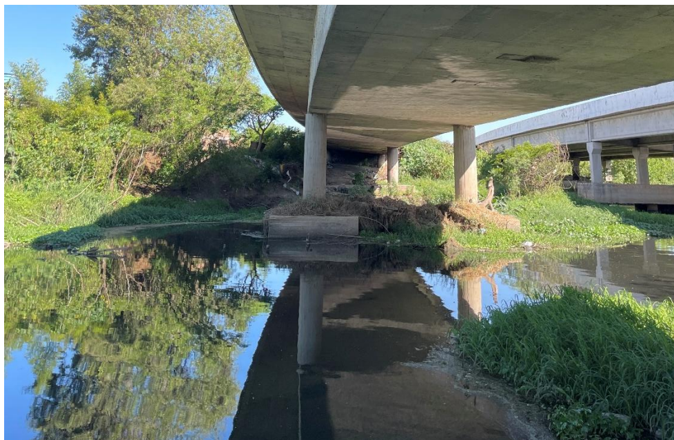
Figura 3 - vista dos blocos de fundações no apoio AP3
