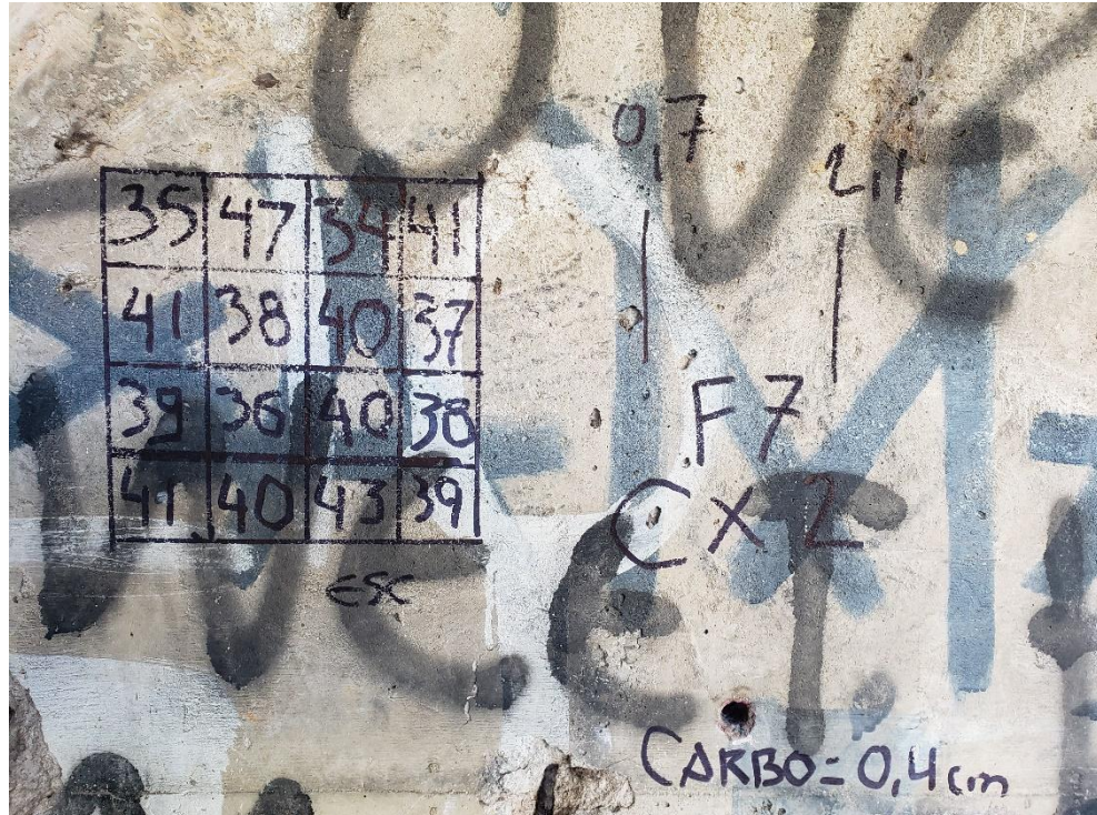
Figura 47 - Ensaio de carbonatação - Carbonatação = 0,4cm
