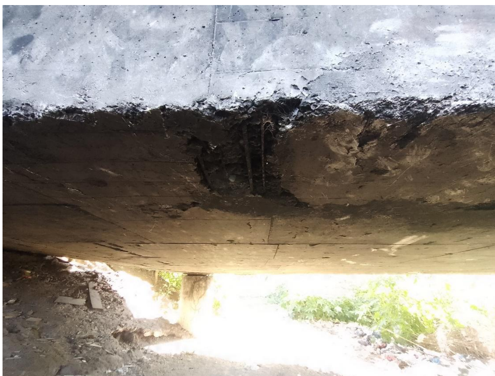
Figura 30 - armadura exposta na laje inferior do caixão
