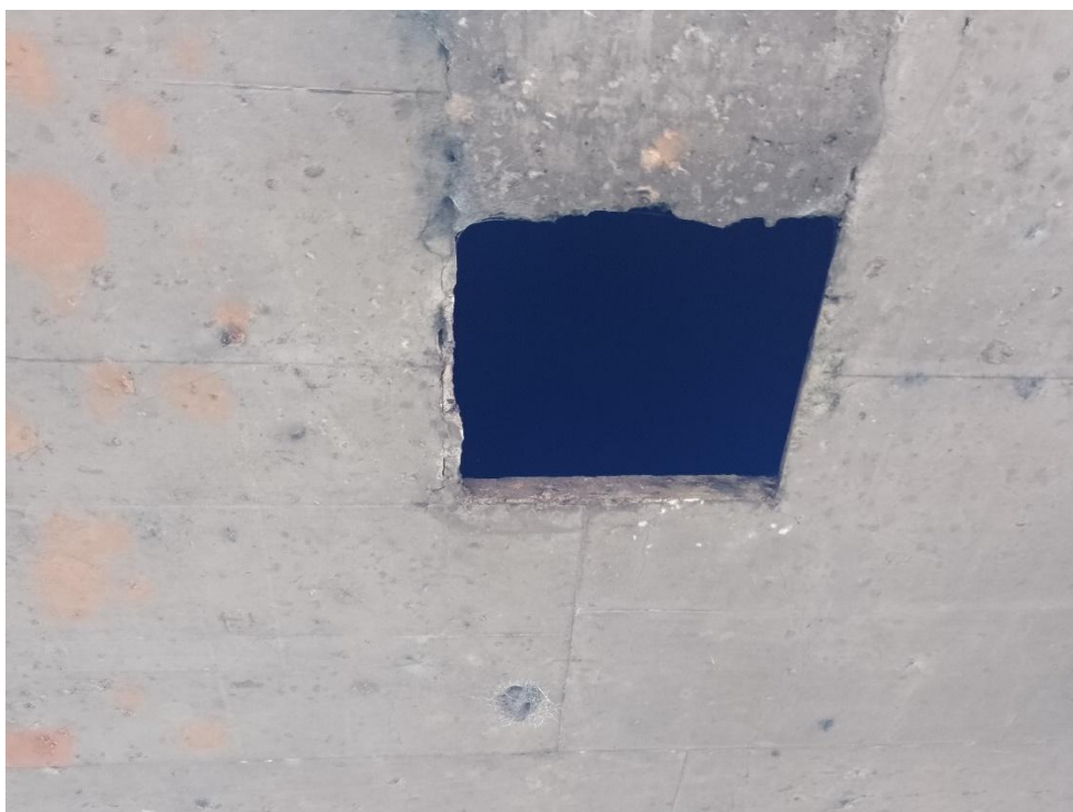
Figura 20 - abertura de inspeção na laje inferior do caixão
