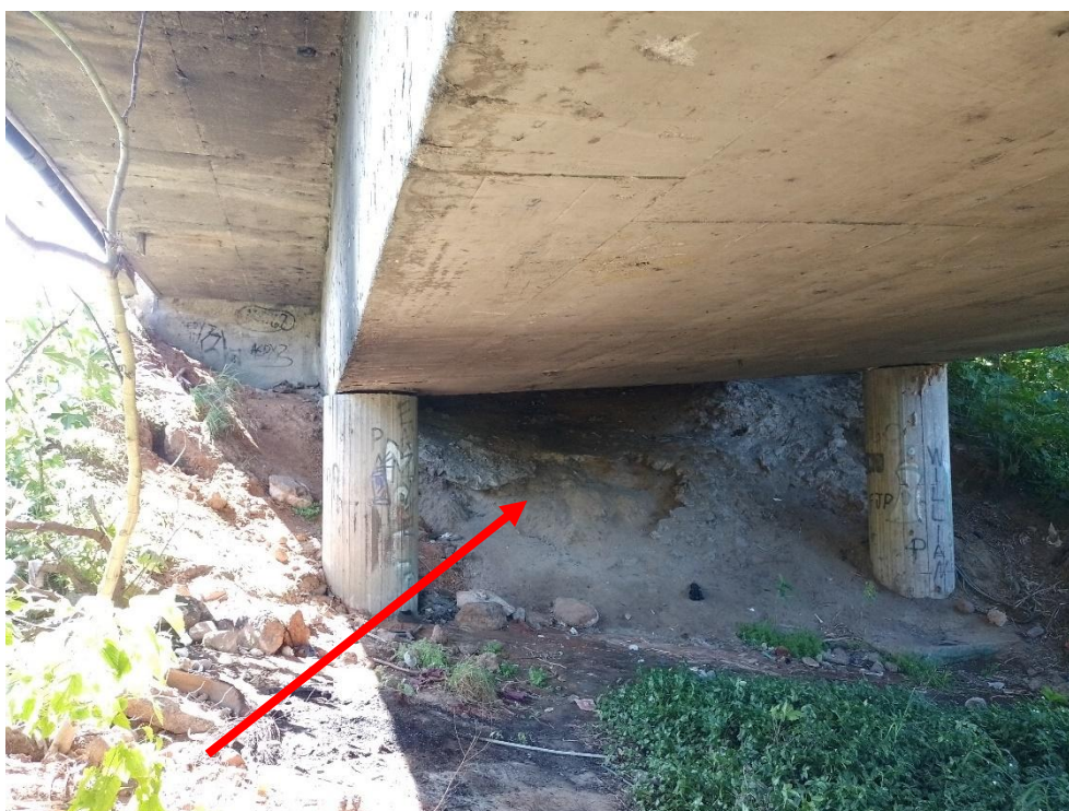
Figura 6 - vista do encontro E2
