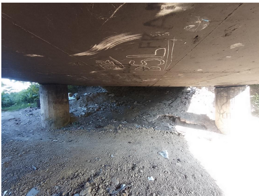
Figura 4 - vista do encontro E1
