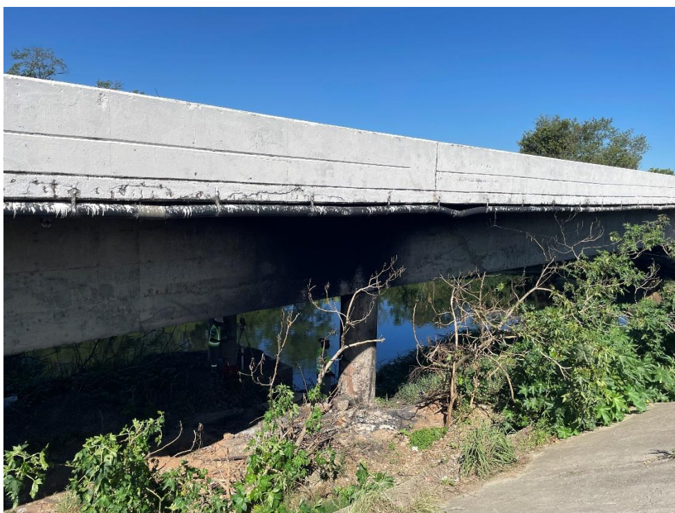
Figura 2 - Vista geral da Ponte
