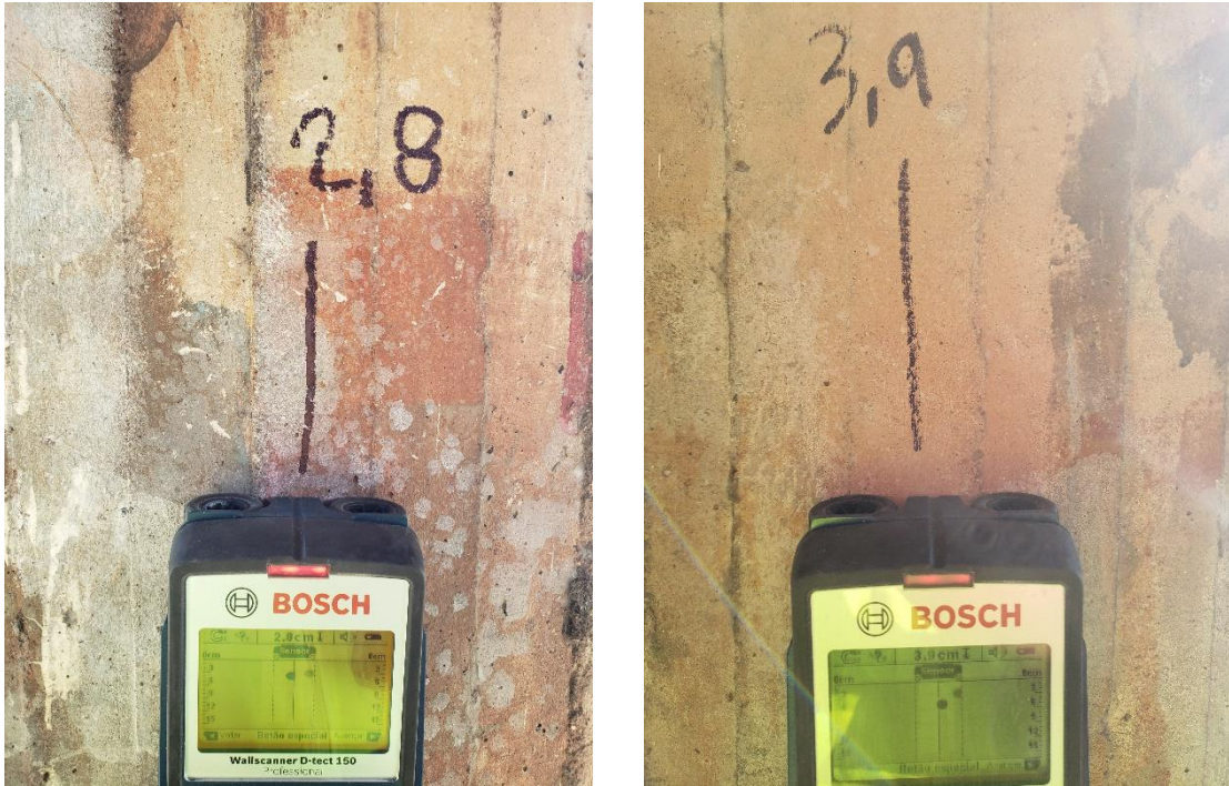
Figura 59 - Ensaio de pacometria - Identificação do posicionamento da armadura existente
