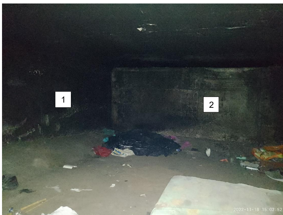
Figura 36 - vista interna do caixão: 1. Parede lateral 2. Transversina sobre o apoio 5
