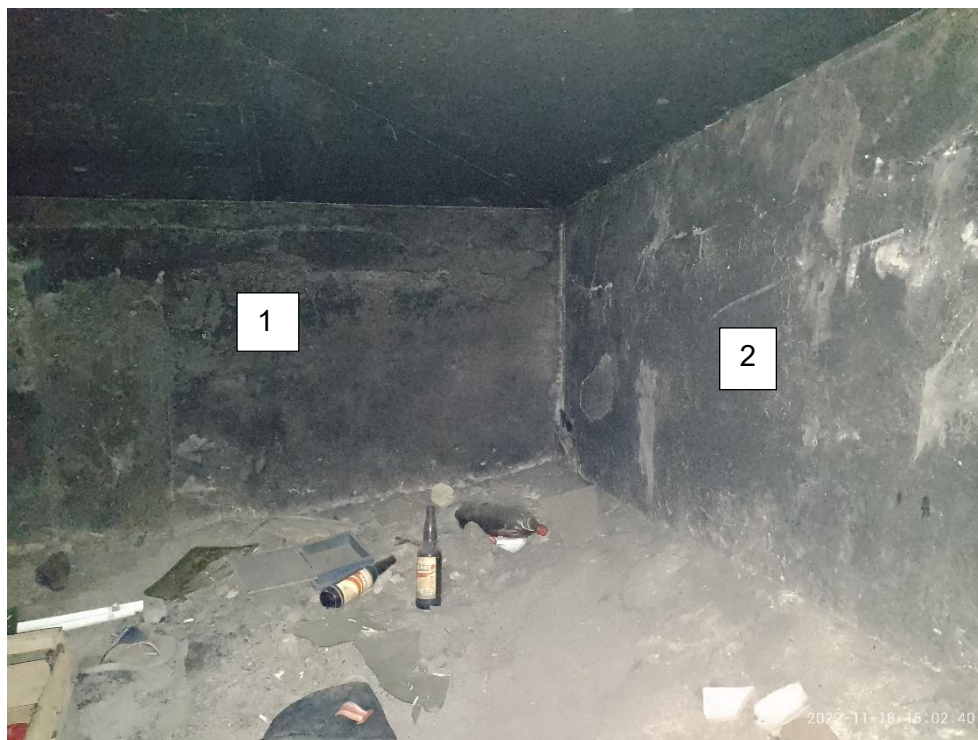
Figura 35 - vista interna do caixão: 1. Parede lateral 2. Encontro E2
