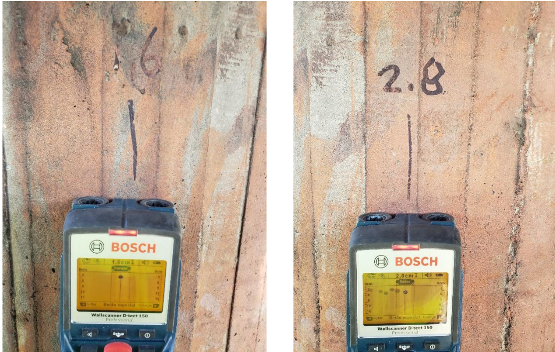
Figura 61 - Ensaio de pacometria - Identificação do posicionamento da armadura existente
