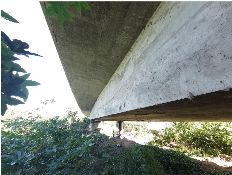
Figura 25 - vista lateral da obra
