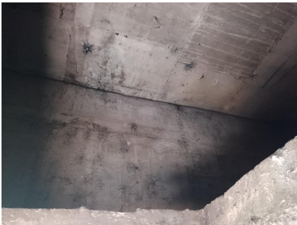
Figura 33 - vista interna do caixão - laje superior
