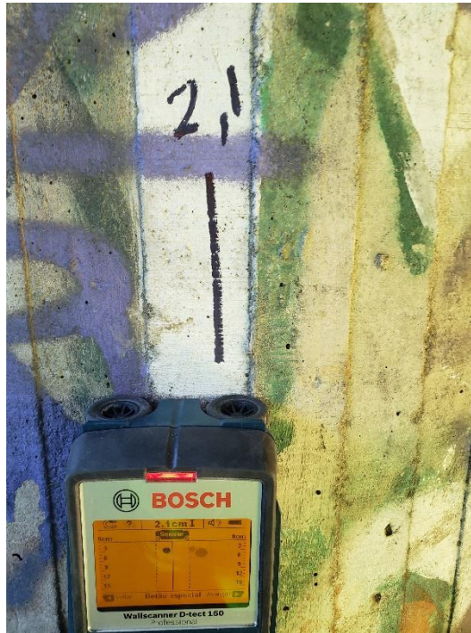
Figura 57 - Ensaio de pacometria - Identificação do posicionamento da armadura existente
